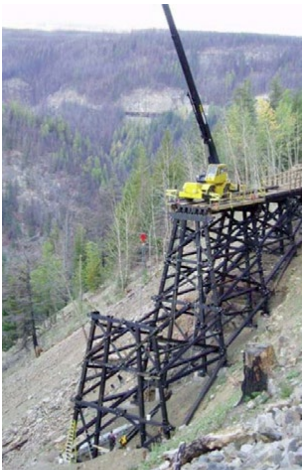
Wiederaufbau von Trestle 11 nach dem Brand
