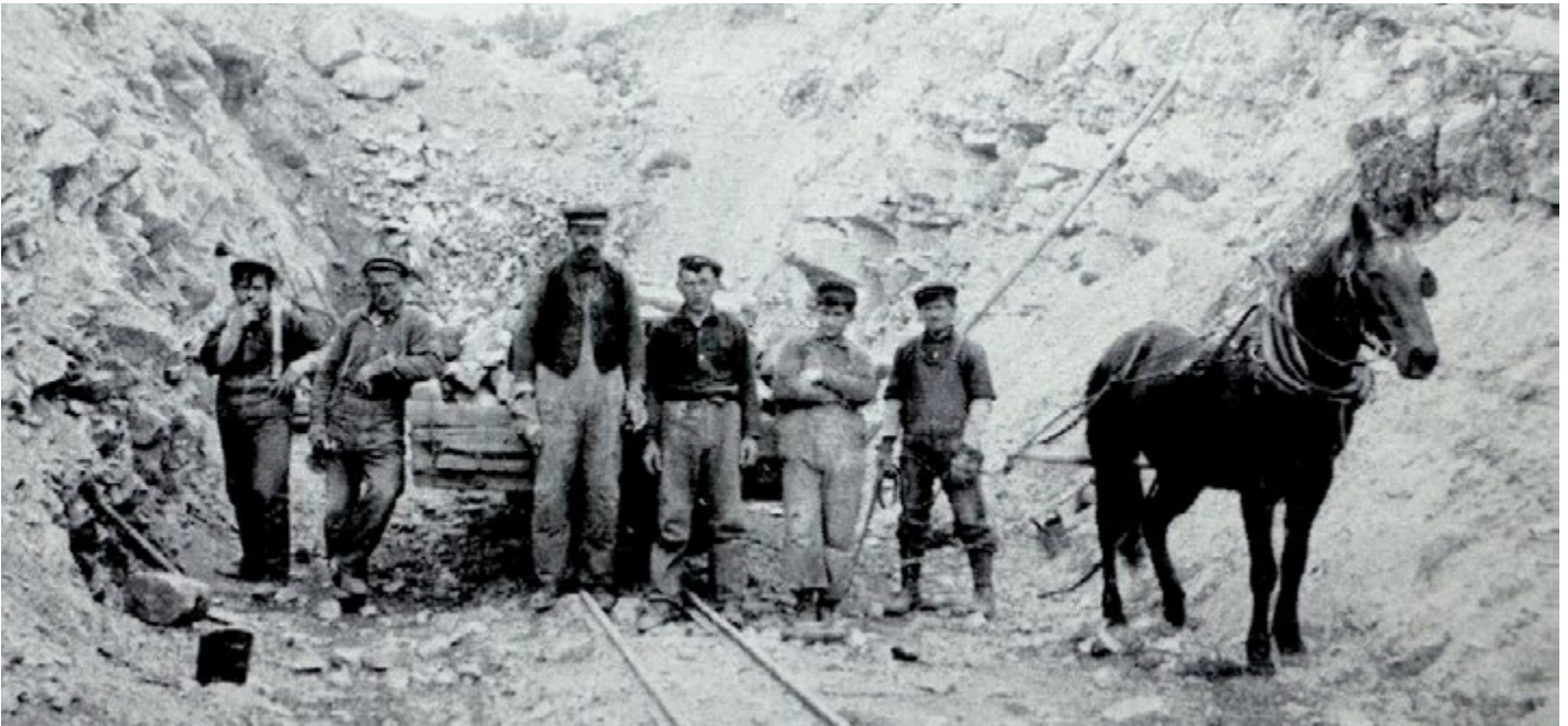
Arbeiter räumen Steine und Schutt vom Bahndamm
