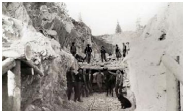
Travaux dans une tranchée creusée dans la roche
