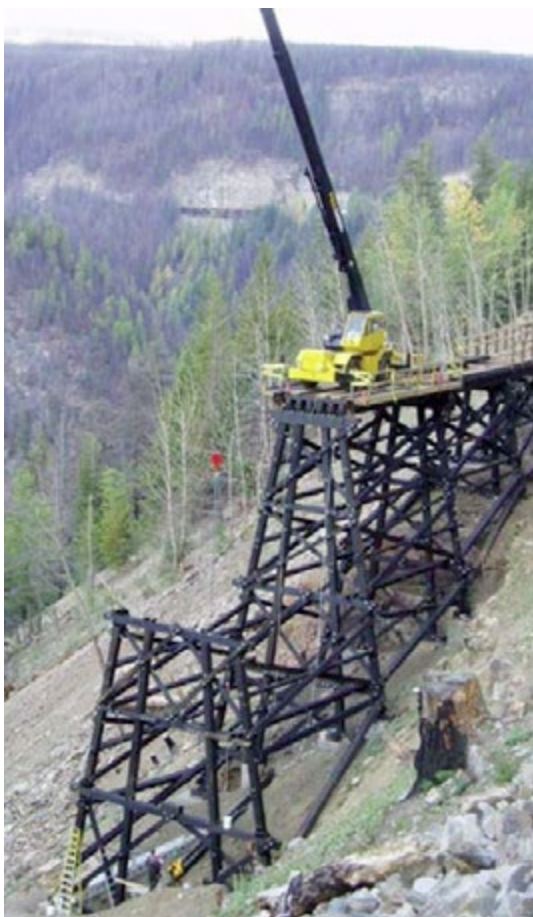
Reconstruction du pont sur chevalets n° 11 après l'incendie
