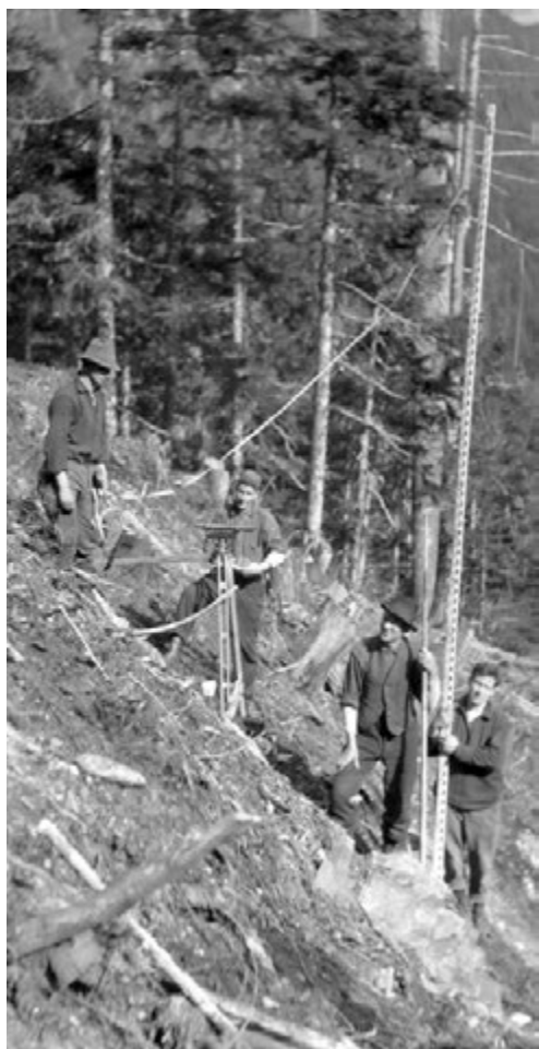
Des géomètres tracent la voie
