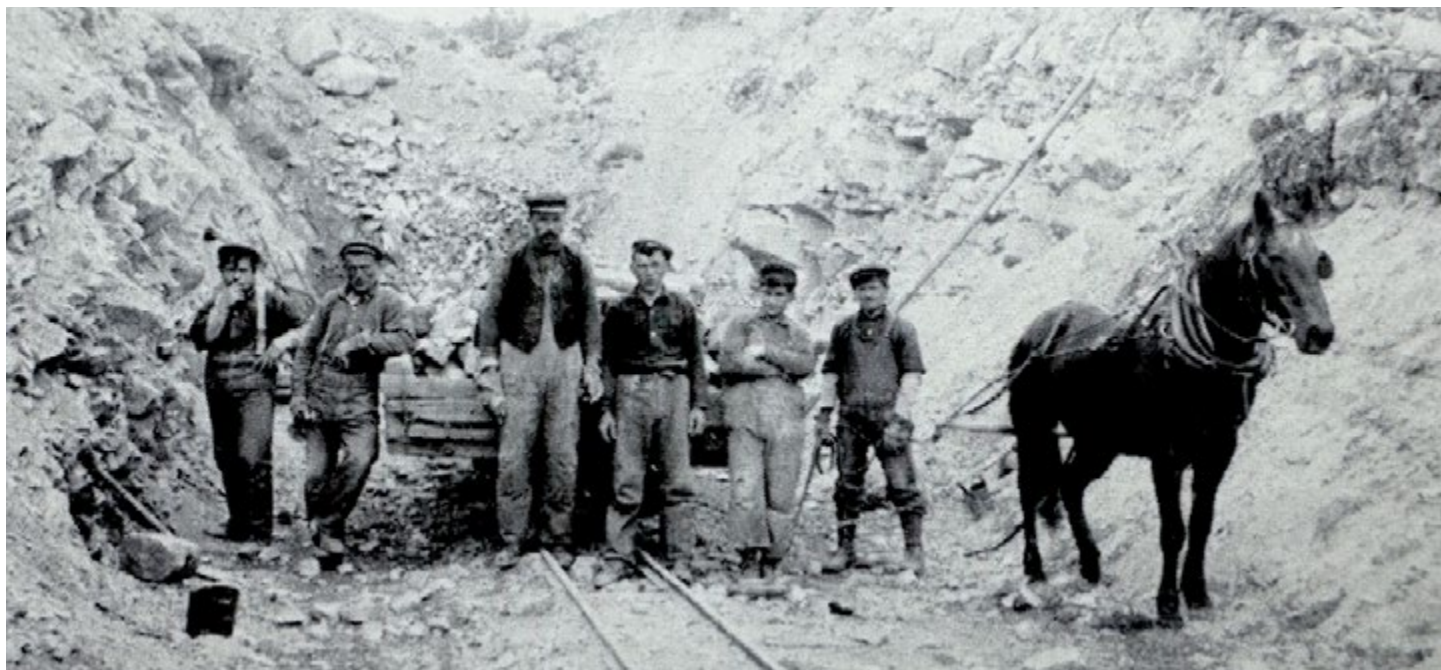
Des ouvriers déblayent les rochers et les débris de l'emprise ferroviaire
