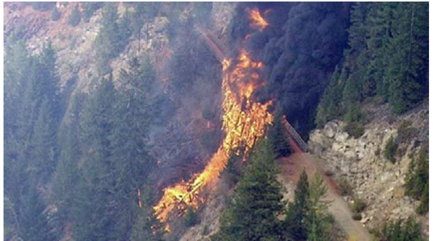
Pont sur chevalets n° 13, feu de l'Okanagan Mountain Park en 2003
